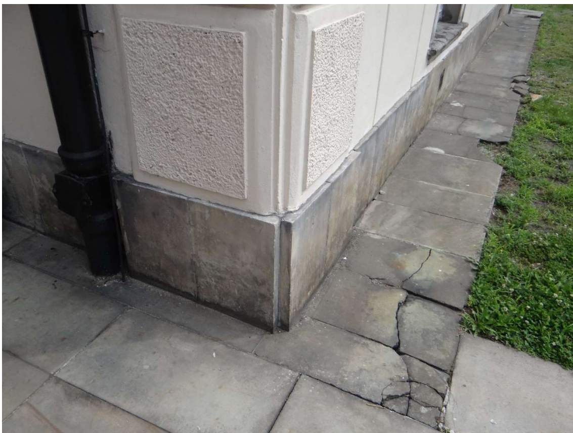
Rys. 12. Stan opaski oraz płyt cokołowych budynku pałacu
