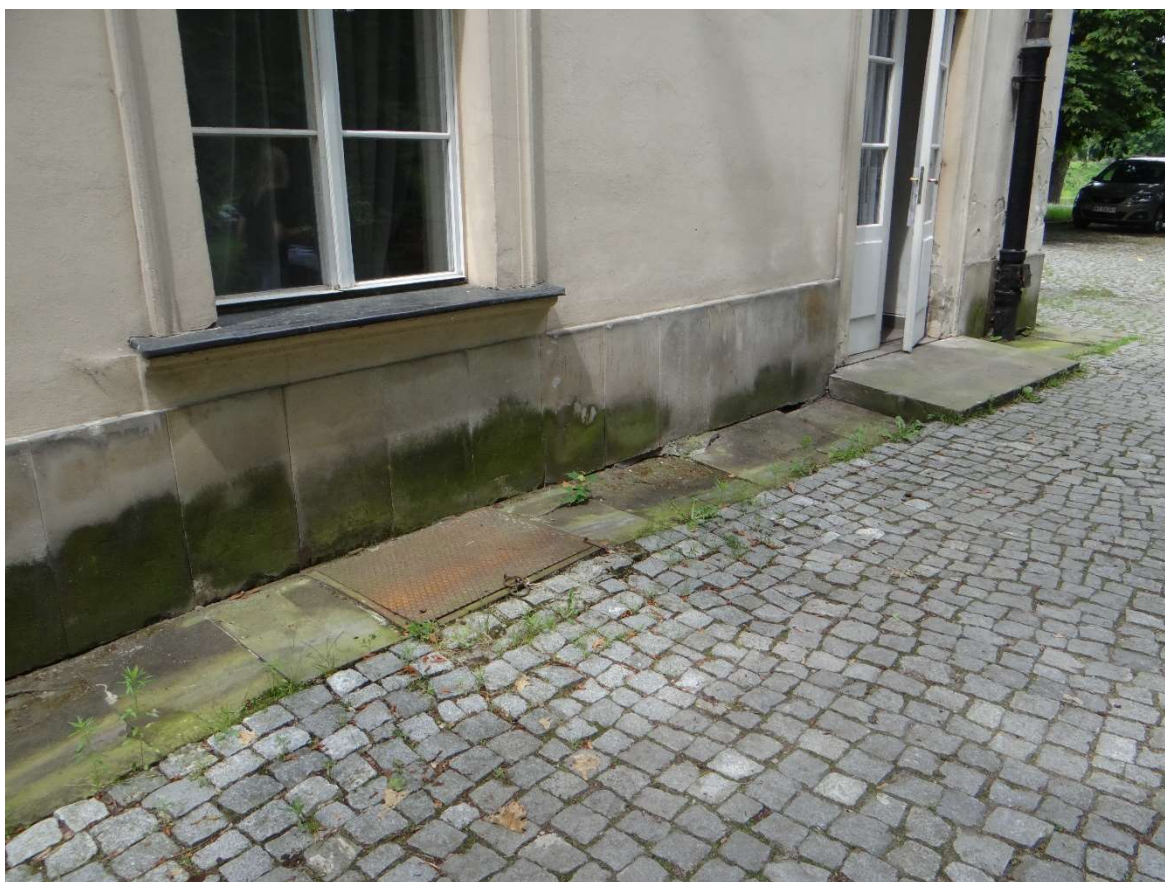
Rys. 2. Stan opaski oraz płyt cokołowych budynku oficyny wschodniej
