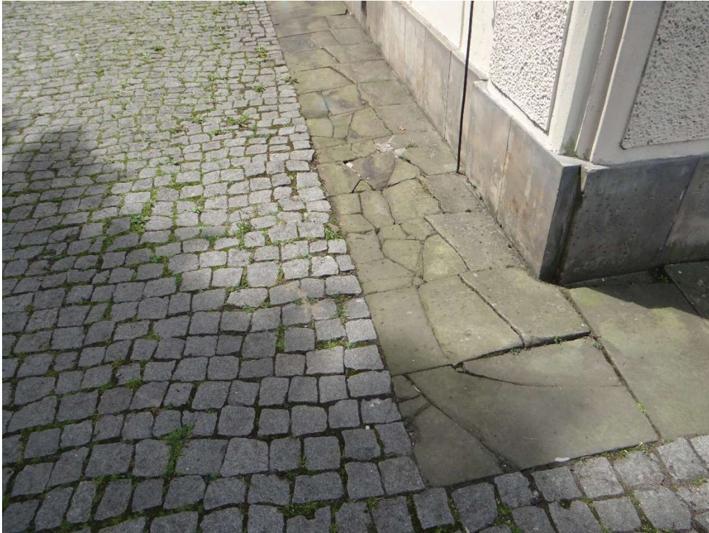
Rys. 5. Stan opaski oraz płyt cokołowych budynku pałacu
