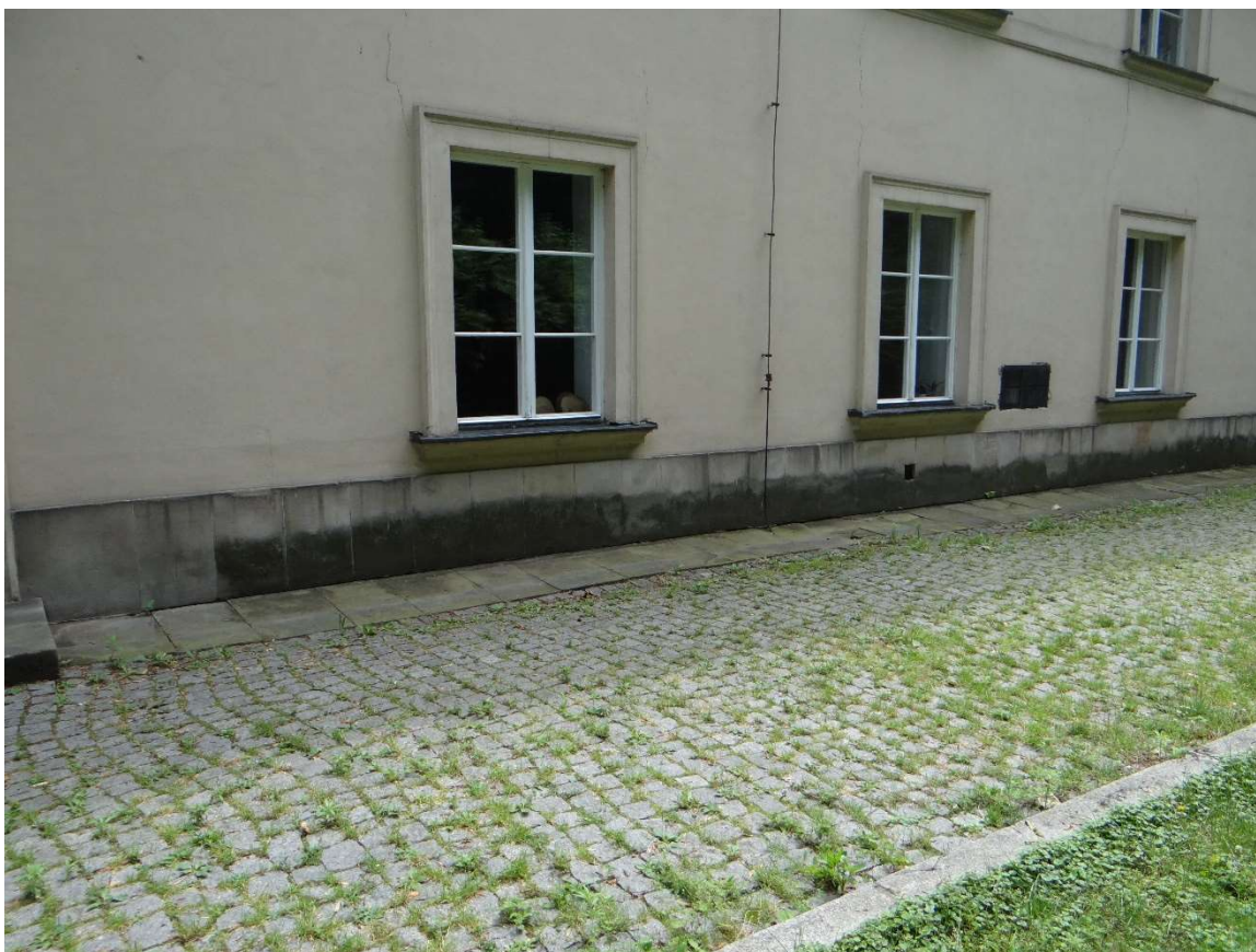
Rys. 15. Stan opaski, nawierzchni oraz płyt cokołowych budynku oficyny zachodniej
