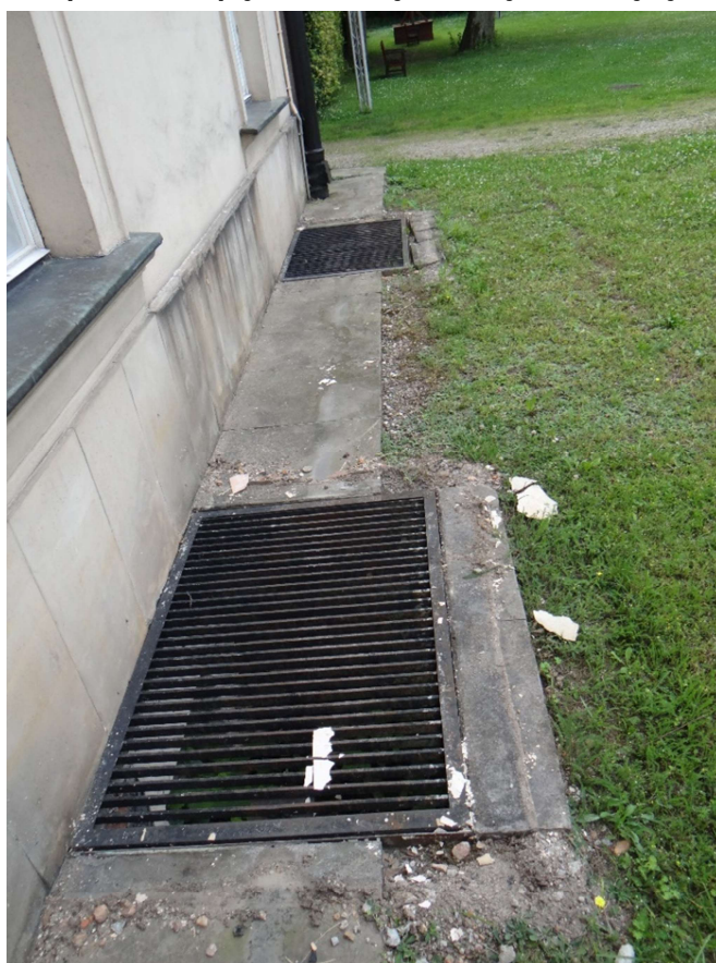
Rys. 4. Stan opaski oraz płyt cokołowych budynku oficyny wschodniej
