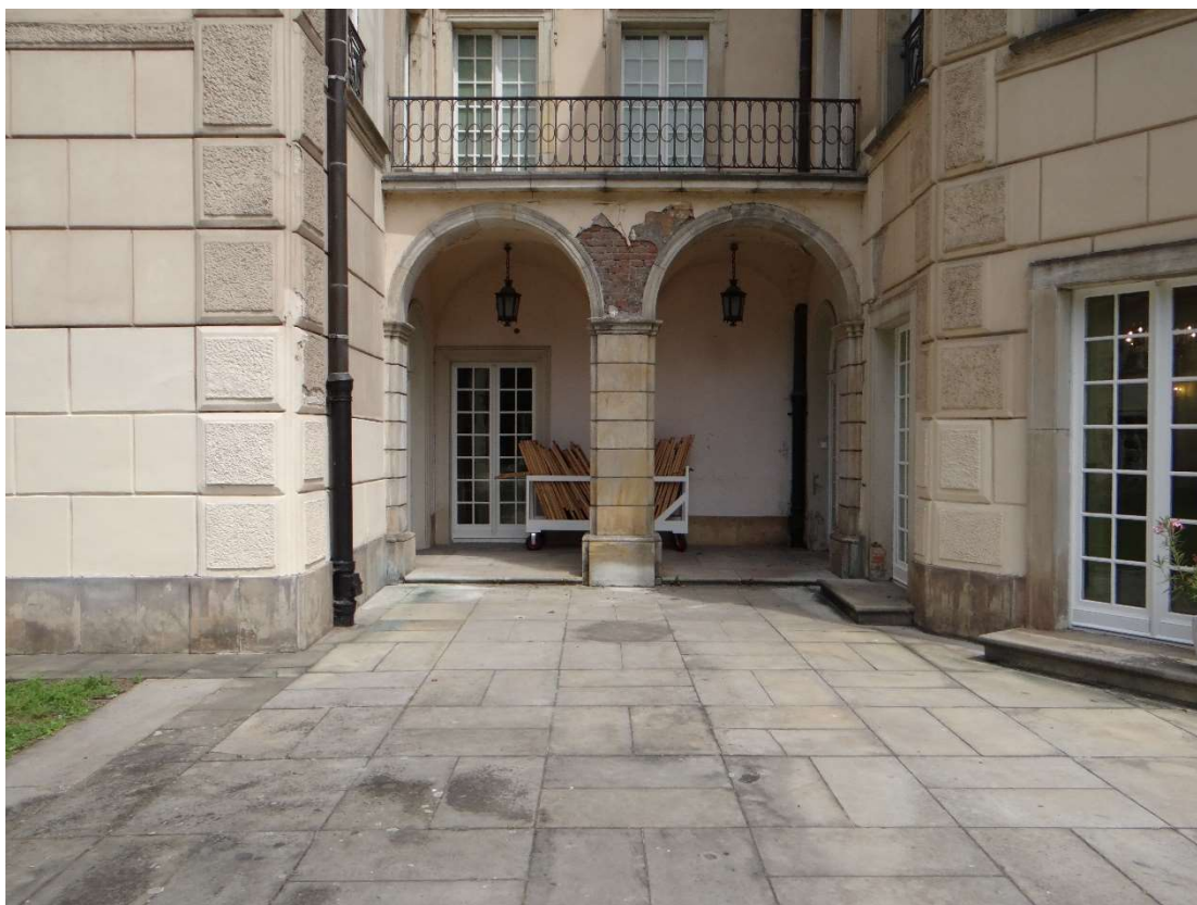
Rys. 10. Stan opaski, płyt cokołowych oraz płyt tarasowych budynku pałacu
