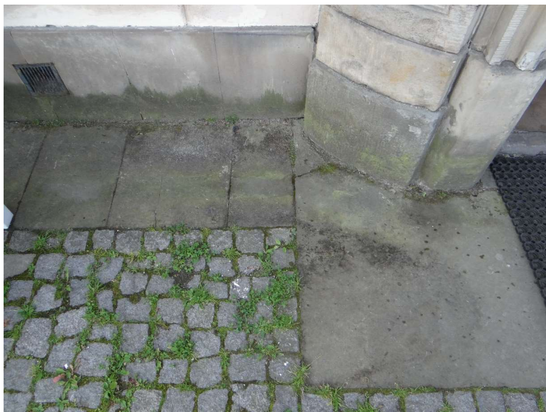
Rys. 8. Stan opaski oraz płyt cokołowych budynku pałacu
