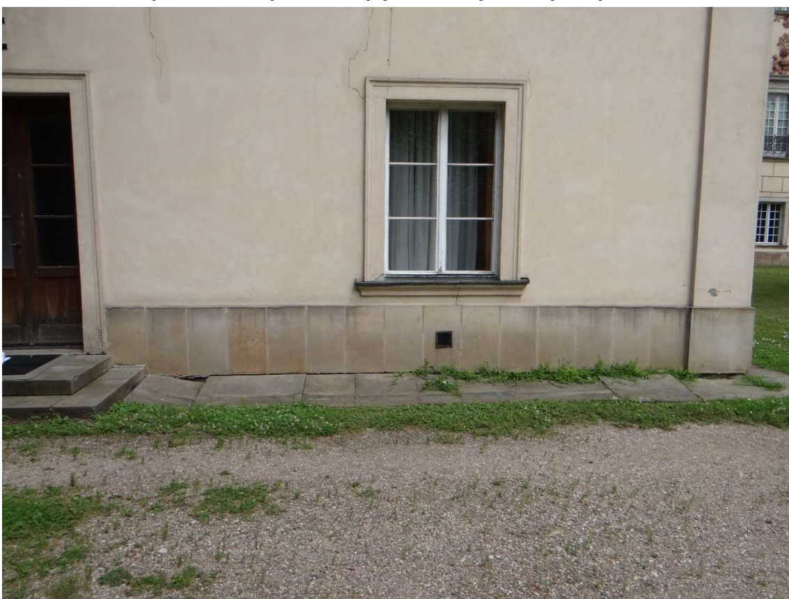
Rys. 12. Stan opaski oraz płyt cokołowych budynku oficyny zachodniej
