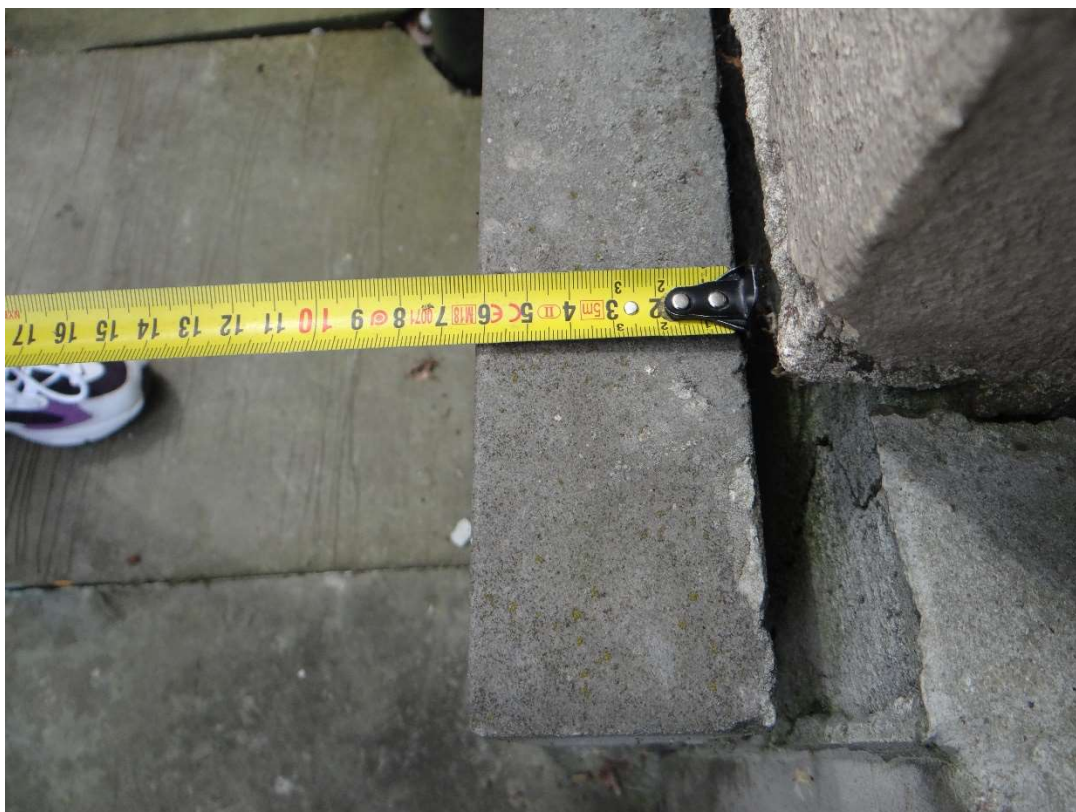
Rys. 9. Stan opaski oraz odspojenie pojedynczej płyty cokołowej budynku pałacu
