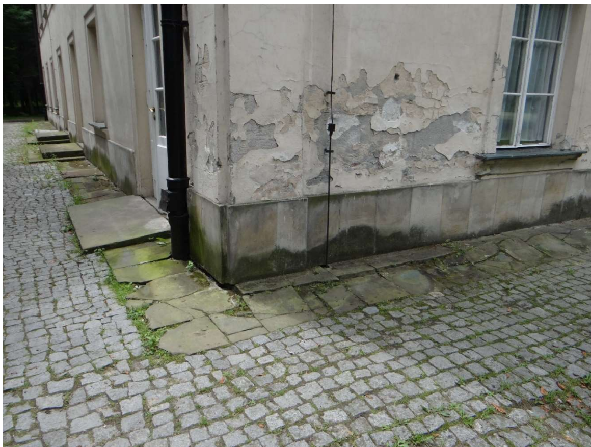
Rys. 1. Stan opaski oraz płyt cokołowych budynku oficyny wschodniej
