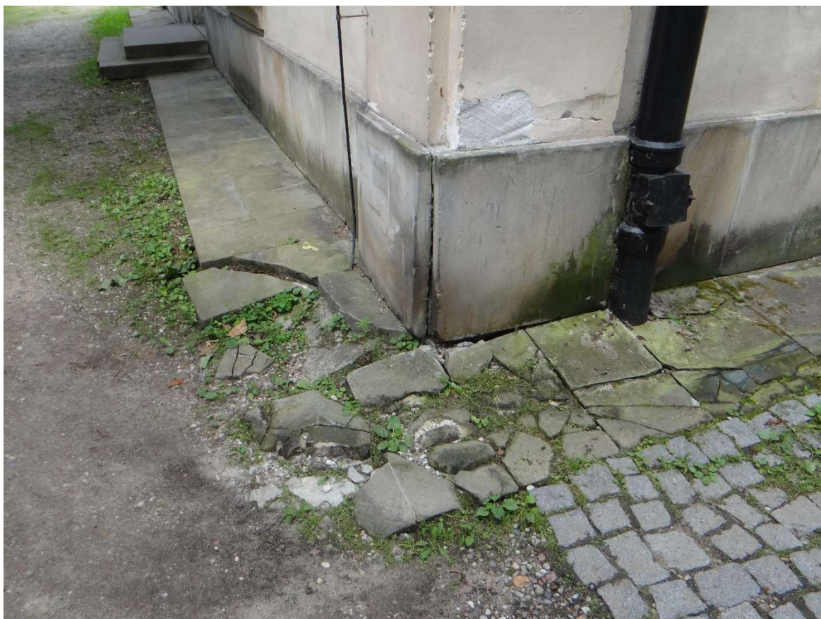
Rys. 3. Stan opaski oraz płyt cokołowych budynku oficyny wschodniej
