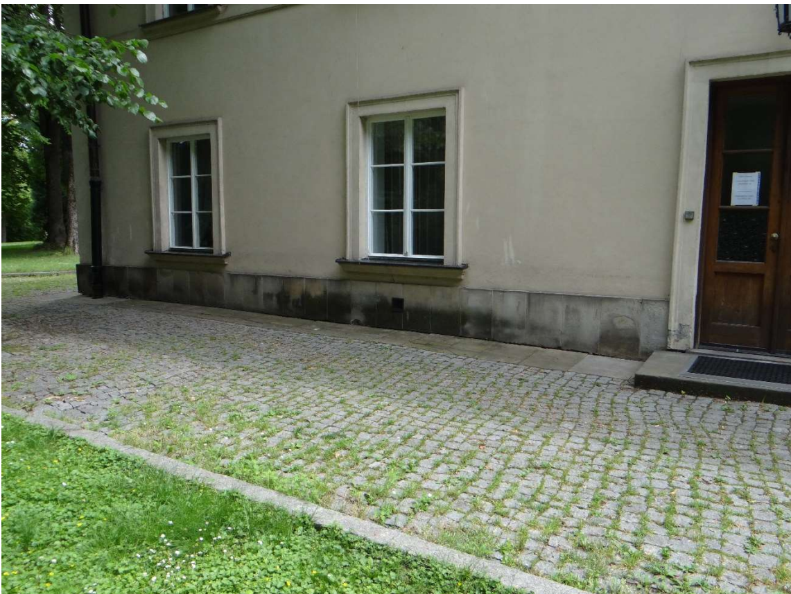
Rys. 14. Stan opaski, nawierzchni oraz płyt cokołowych budynku oficyny zachodniej
